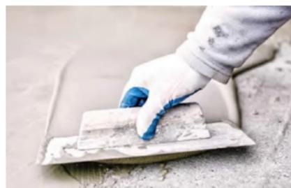
Estenda a argamassa no contrapiso com o lado dentado da desempenadeira, em uma área suficiente para o assentamento de 12 peças.
