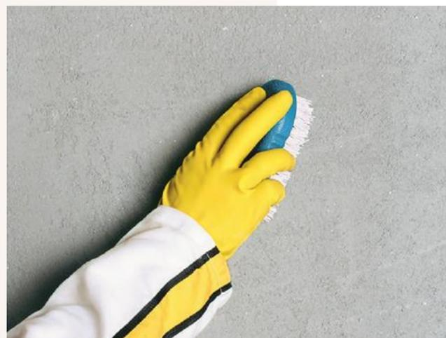
Inspeção da base. Se necessário, proceda as regularizações. Não impermeabilize o emboço.
