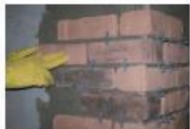
Para melhor estética do painel indicamos a utilização da junta seca (sem espaçamento). Caso deseje rejuntar o painel, assente o produto com espaçador de no mínimo **3mm\***.
