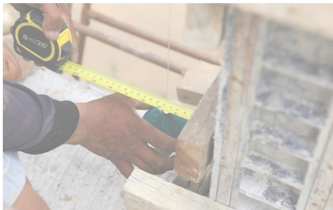
Alinhamento e nivelamento para que as peças sejam instaladas sem desníveis.
