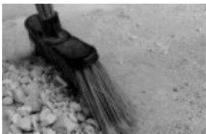
Utilizando uma broxa de pintura, umedeça a base e remova qualquer tipo de resíduo.
