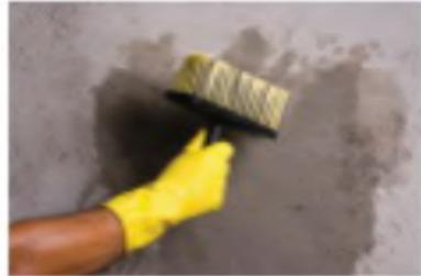
Utilizando uma broxa de pintura, umedeça a parede e remova qualquer tipo de resíduo.
