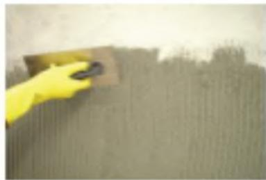
Estenda a argamassa na parede com o lado dentado da desempenadeira, em uma área suficiente para o assentamento de 12 peças.
