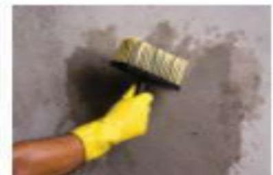
Utilizando uma broxa de pintura, umedeça a parede e remova qualquer tipo de resíduo.
