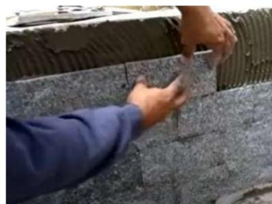
Para melhor estética do painel utilize **junta seca** (sem espaçador). Caso prefira rejuntar, assente o produto com espaçador de no mínimo **3 mm\***. Pressione com as duas mãos a peça contra a parede. Nunca utilize o cabo da colher para ajudar nesta tarefa.
