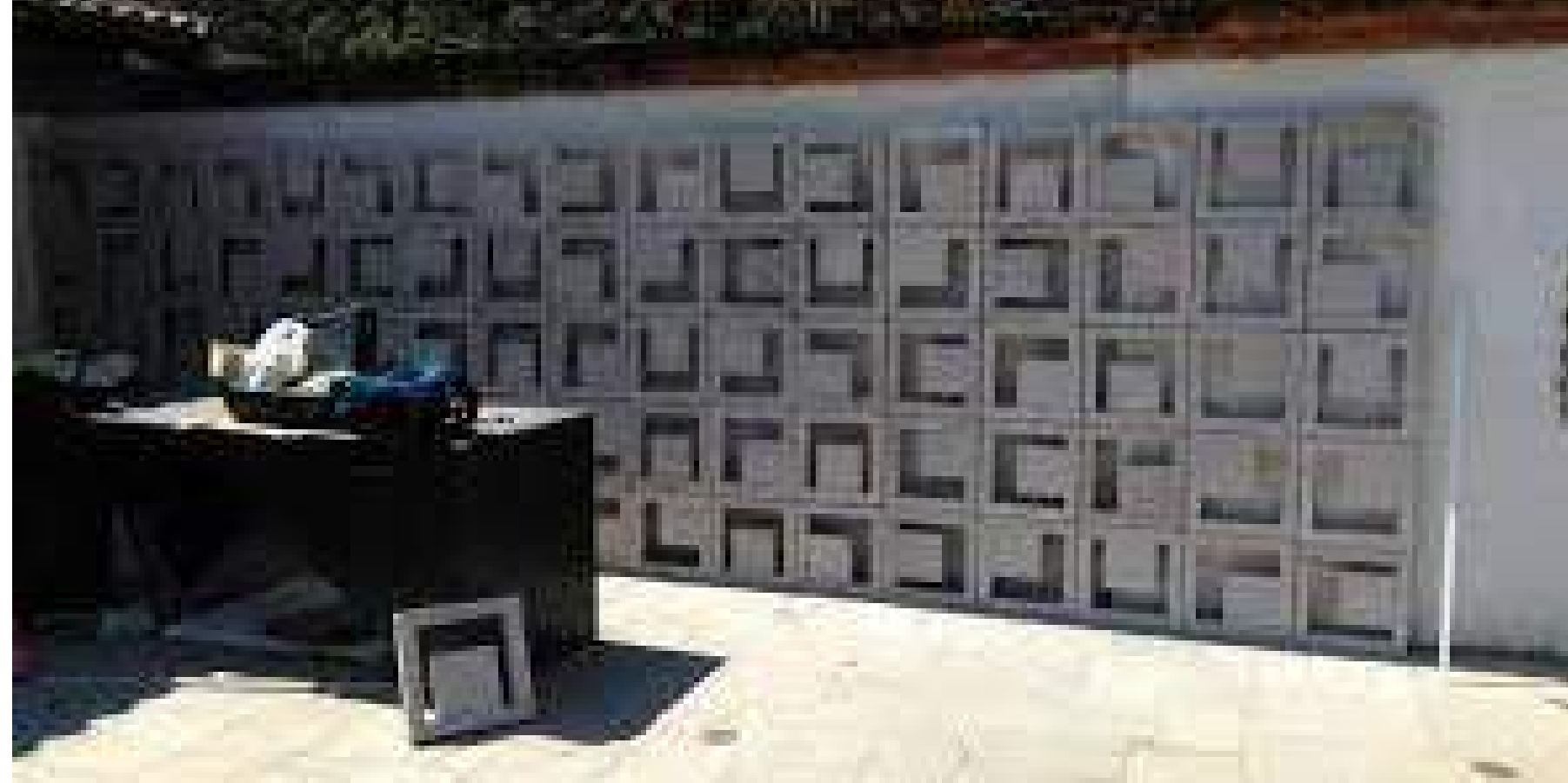
Instalação e assentamento de cobogós *modelo ilustrativo
