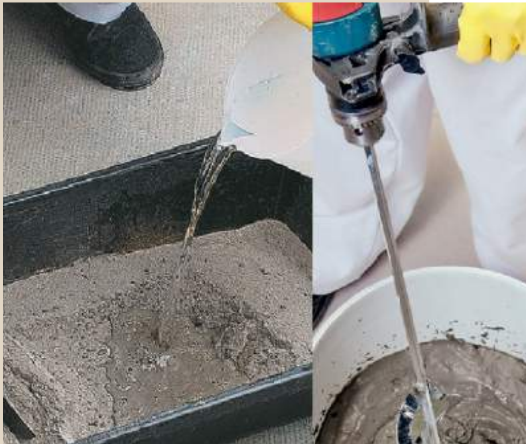
Adição de água para a argamassa e sua mistura com a haste helicoidal da furadeira.
