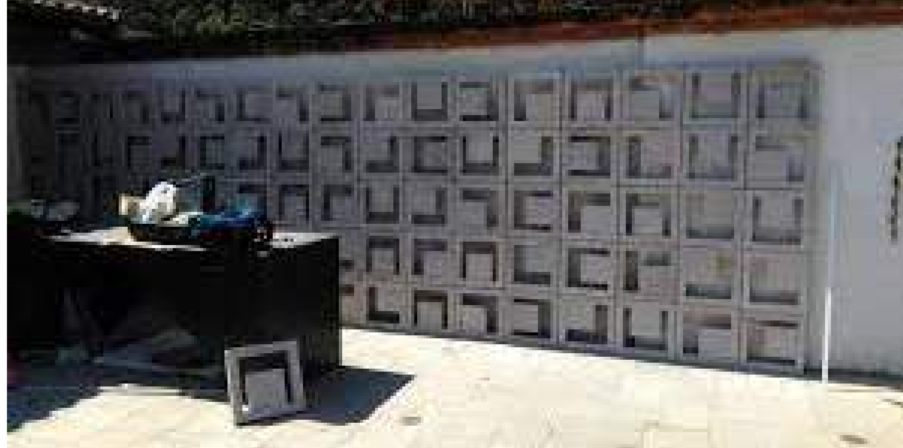
Instalação e assentamento de cobogós. *imagem ilustrativa
