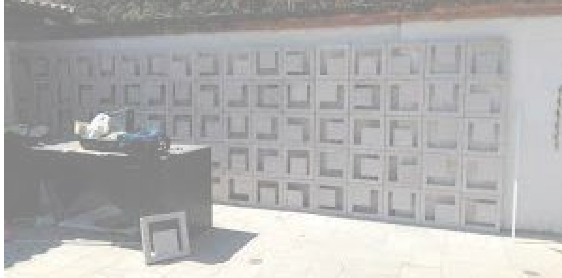
Instalação e assentamento de cobogós *modelo ilustrativo
