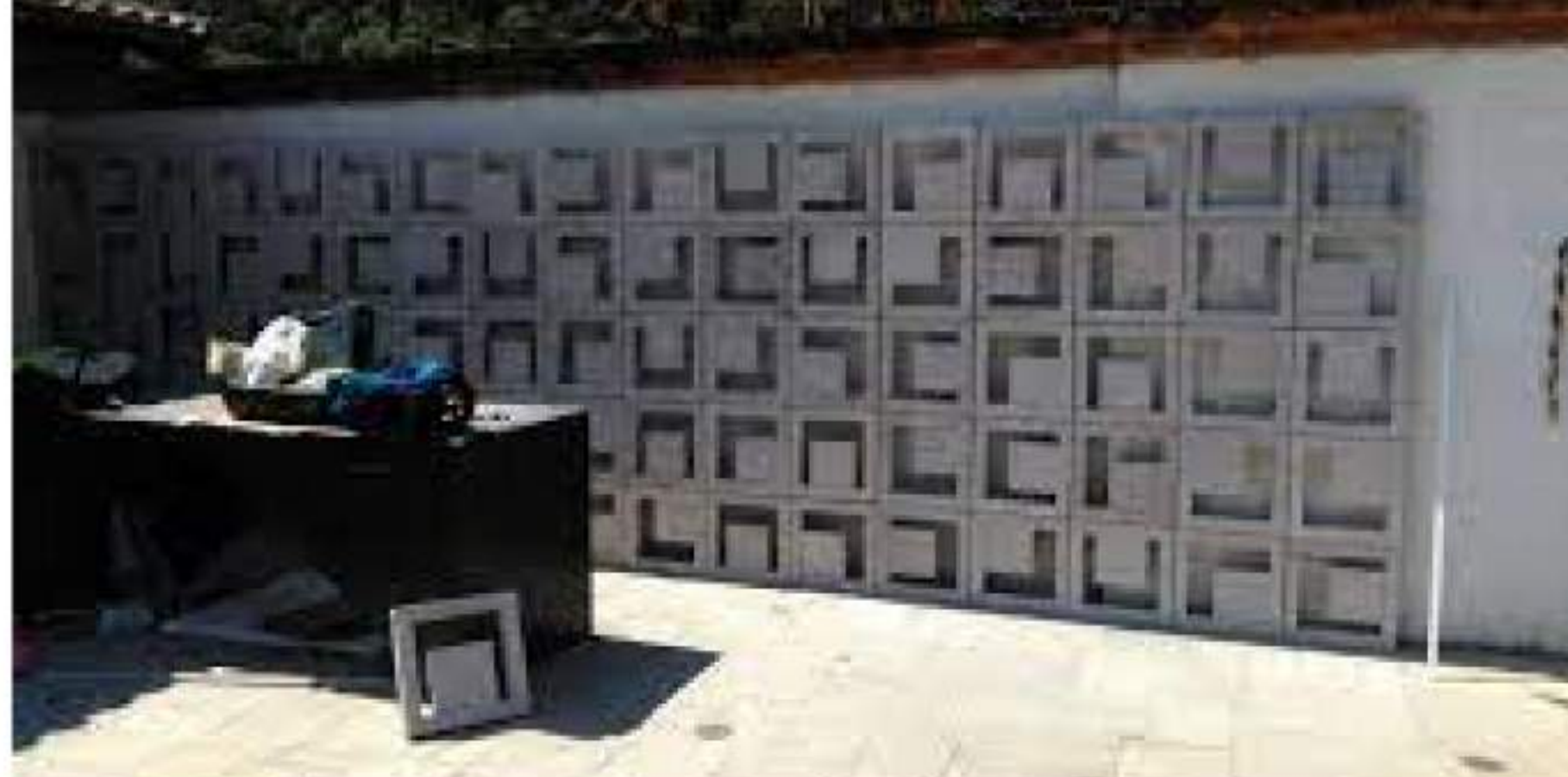
Instalação e assentamento de cobogós. *imagem ilustrativa
