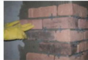
Para melhor estética do painel utilize junta seca (sem espaçador). Caso prefira rejuntar, assente o produto com espaçador de no mínimo **3mm\***. Pressione com as duas mãos a peça contra a parede. Nunca utilize o cabo da colher para ajudar nesta tarefa.
