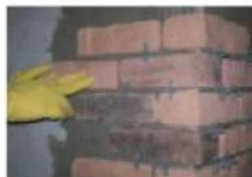
Para melhor estética do painel utilize junta seca (sem espaçador). Caso prefira rejuntar, assente o produto com espaçador de no mínimo **3mm\***. Pressione com as duas mãos a peça contra a parede. Nunca utilize o cabo da colher para ajudar nesta tarefa.
