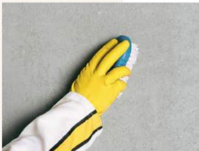
Inspeção da base. Se necessário, proceda as regularizações. Não impermeabilize o emboço.
