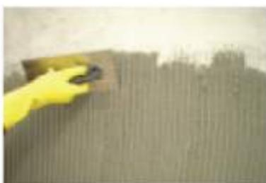
Estenda a argamassa na parede com o lado dentado da desempenadeira, em uma área suficiente para o assentamento de 12 peças.
