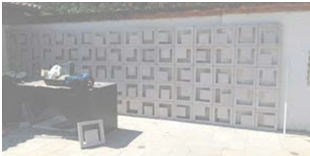
Instalação e assentamento de cobogós *modelo ilustrativo
